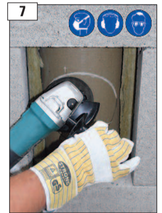
7 Äußeren Querschnitt mit Winkelschleifer als "Sollbruchstelle" anschneiden.
