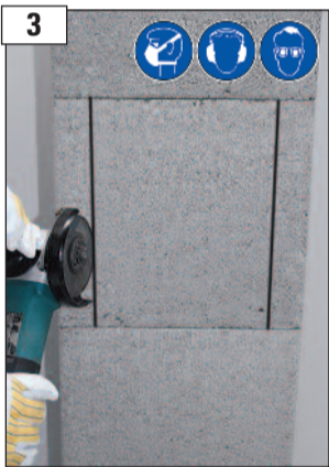
3 Mantelstein mit Winkelschleifer an den Markierungslinien aufschneiden.
