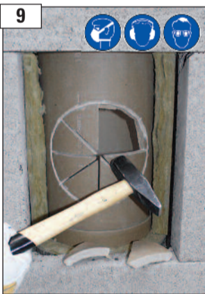
9 Schamotteteile vorsichtig mit Hammer entfernen.
