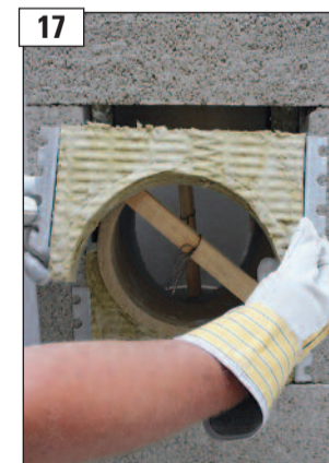
17 Haltewinkel auf Mineralfaserfrontplatte aufstecken und einbauen.
