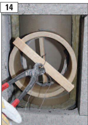
14 Rauchrohrstutzen am Schamottrohr feströdeln.
