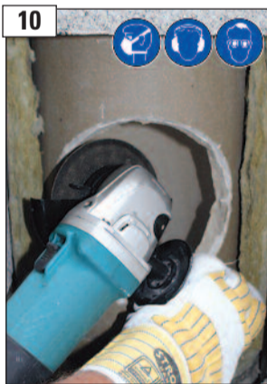
10 Unebenheiten an der Sollbruchstelle mit Winkelschleifer nacharbeiten.
