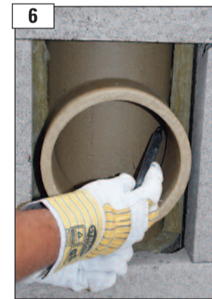
6 Rauchrohrstutzen als Schablone verwenden und entlang des inneren Durchmessers anreißen.
