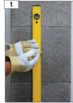
1 Anschlusshöhe der gewünschten Rauchrohröffnung ermitteln.
