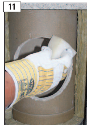
11 Schnittfläche mit feuchtem Schwamm säubern.
