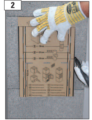
2 Unter Verwendung der Schnittschablone Mantelsteinöffnung anreißen.
