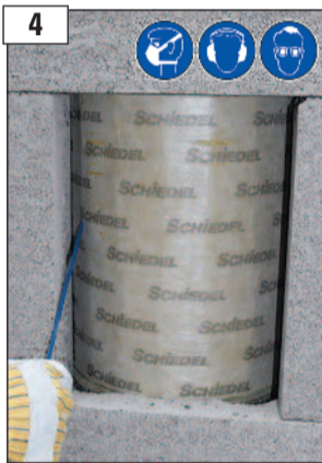
4 Dämmung mittels Sägeblatt entlang der Hinterlüftungskanäle aufschneiden ...
