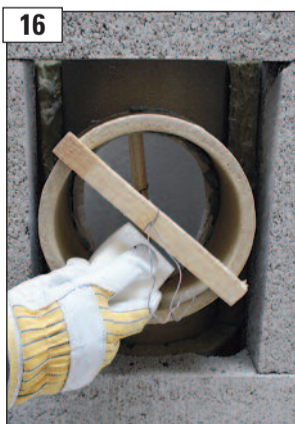
Kittreste vorsichtig mit Schwamm entfernen. WICHTIG: Trockenzeit beachten!
