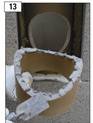
13 Schiedel-Fugenkitt auf Rauchrohrstutzen auftragen.
