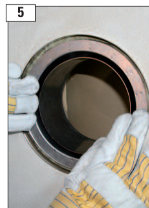
Anschlagring des Anschlussfutters muss dicht am Schamotterstutzen angepresst sein.
