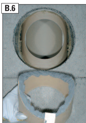
B.6 Nach Reinigung beider Kittflächen Schiedel-Fugenkitt auf die Rauchrohrstutzen auftragen.
