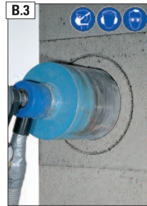
B.3 Für den inneren Querschnitt, mit kleiner Bohrkronen, vorsichtig durch Mantelstein und Schamotterrohr bohren.
