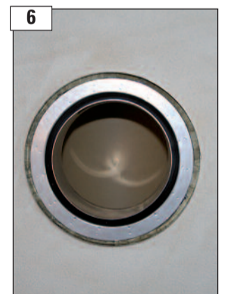
Fertigansicht des eingebauten Anschlussfutters mit Keramikdichtband.
