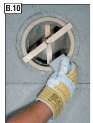
B.10 Kittreste vorsichtig mit Schwamm entfernen.
