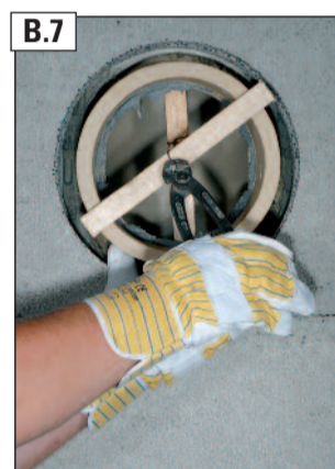
B.7 Rauchrohrstutzen am Schamotterrohr feströdeln.
