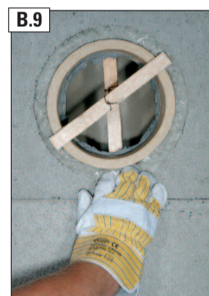
B.9 Rauchrohrstutzen mit Dichtschnur abdichten.
