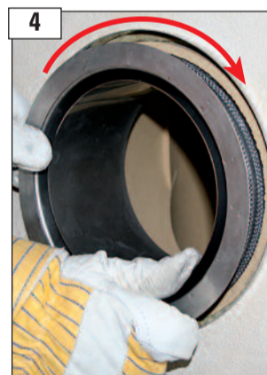
Anschlussfutter mit aufgewickelm Keramikdichtband in das Schamotteanschlussformstück in Wickelrichtung hineindrehen.
