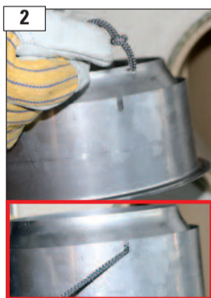
An einem Ende des Keramikdichtbandes einen Knoten binden und das Knotenende des Keramikdichtbandes in den Knotenfänger des Anschlussfutters einhängen.
