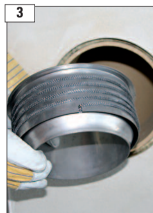
Keramikdichtband spiralförmig und straff um das Anschlussfutter wickeln. WICHTIG: Ende des Keramikdichtbandes am Schluss festhalten!
