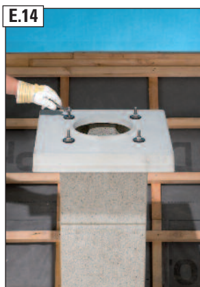
E.14 Handy-Abdeckplatte mit Muttern M12 aus Edelstahl (C) kraftschlüssig verschrauben.
