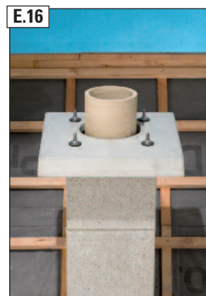
E.16 Schamotterrohr zuschneiden und versetzen (gemäß SIH-Versetzanleitung zu ihrer Abgasanlage).
