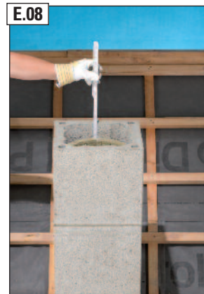
E.08 Die letzten Dämmplatten enden 8 cm unter Oberkante Mantelstein.
