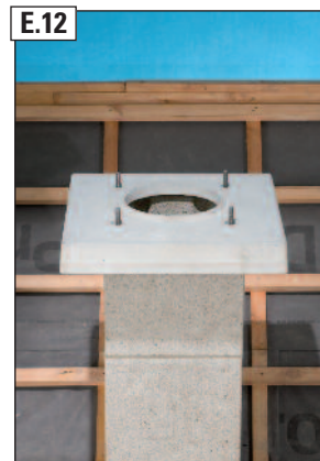
E.12 Handy-Abdeckplatte aufsetzen.
