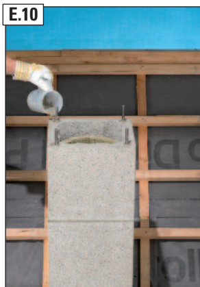
E.10 Vergussmörtel in die Bewehrungskanäle einbringen.
