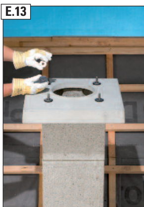
E.13 Zuerst die Unterlegscheiben aus Kunststoff (A), darauf die Unterlegscheiben aus Edelstahl (B) über die Edelstahlgewindestäbe (G) stülpen.
