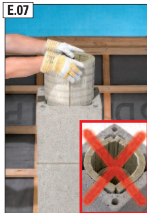
E.07 Dämmplatten biegen, einsetzen und gemeinsam nach unten schieben. WICHTIG: Die Hinterlüftungskanäle müssen freibleiben!
