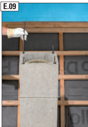
E.09 Edelstahlgewindestangen (G) aus dem Befestigungsset in die Gewindehülsen der Bewehrungsstäbe eindrehen.
