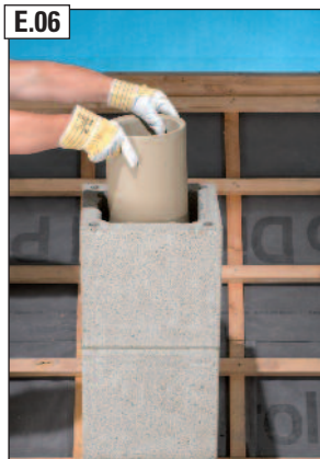
E.06 Schamotterrohr versetzen (gemäß SIH-Versetzanleitung zu ihrer Abgasanlage).
