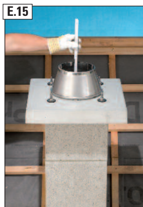
E.15 Abströmkonus aufsetzen und fehlende Rohrlänge ausmessen.
