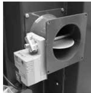
Stellung der Klappe beim Betrieb mit Pellets.
