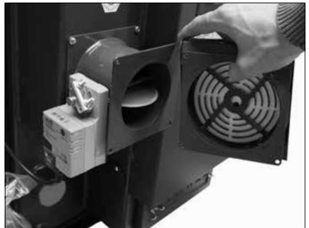
Inspektion und Reinigung des mit einem Regulationsklappe ausgestatteten Luftkanals
