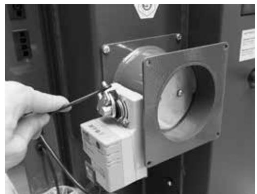
Stellung der Klappe beim Betrieb mit Braunkohlebriketts.
